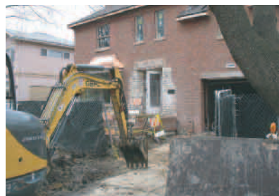
"ガット"リハブの例。 外壁と土台以外はすべて改築
